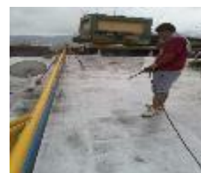
lavado para impermeabilización
