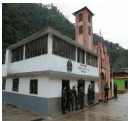
Nueva estación de Policía, Puerto Saldaña. Rioblanco
