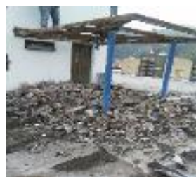
Demolición y retiro de tragaluz
